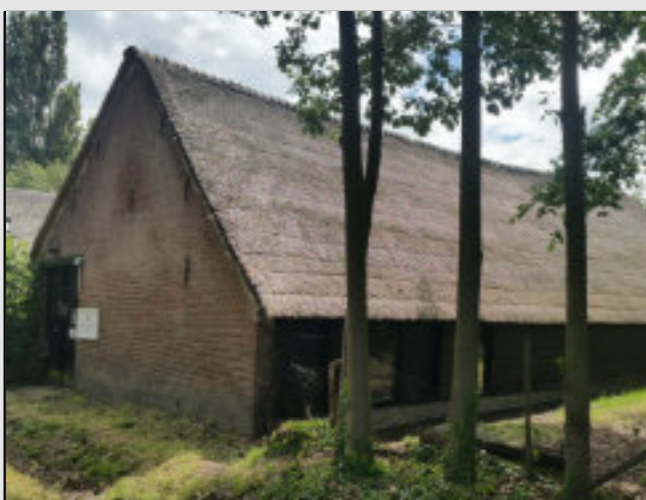
Vlaamse schuur 't Peerdeke , Breda (NB) Multifunctionele ruimte voor o.a. workshops, vergaderingen, lezingen, exposities en retraites i.c.m. logies
